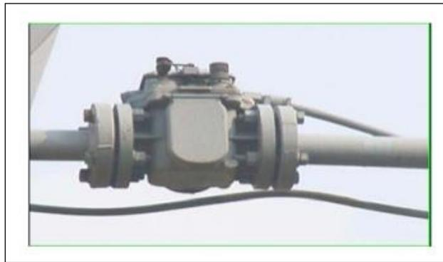
**Gambar 2.8 Bentuk Fisik dari Rele Bucholtz**
