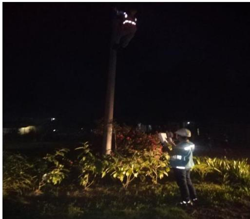
Gambar 3.11 pengukuran tegangan di tiang malam hari (Sumber : Dokumentasi Pribadi )
