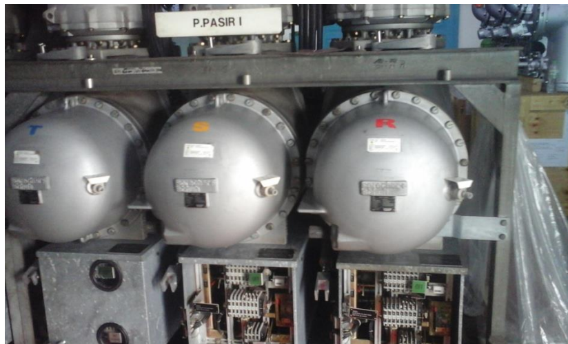
Gambar 2.3 Pemutus Tenaga pada GIS dengan penggerak motor Sumber : (Gardu induk Mabar ,2019)
