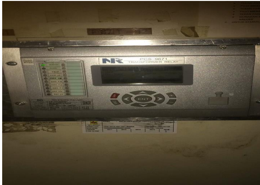
Gambar 2.17 Relay Diferensial Gardu Induk Mabar NR 9671 (Sumber :Gardu induk mabar,2019)
