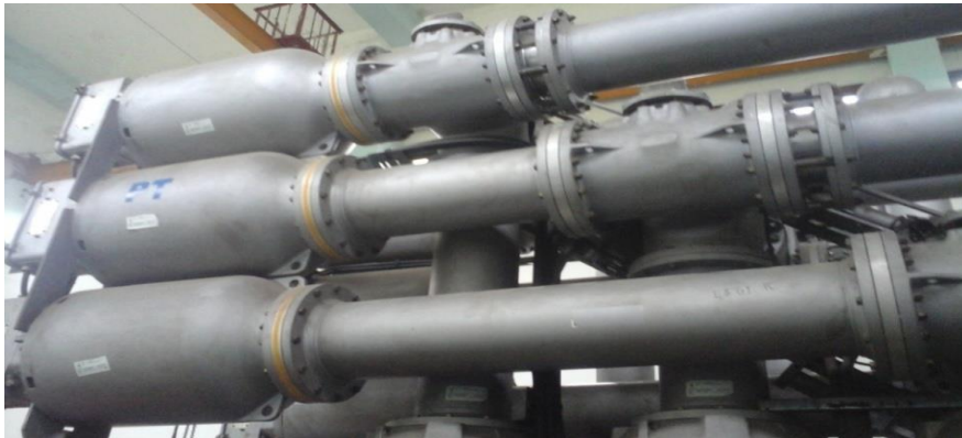
Gambar 2.5 Trafo Tegangan (Sumber :gardu induk mabar,2019)
