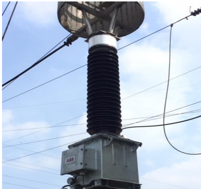
Gambar 2.8 CVT GI Mabar (Sumber: Gardu induk mabar, 2019)
