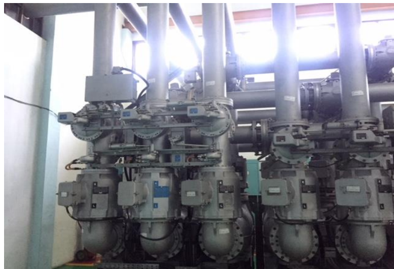
Gambar 2.1 Gardu Induk Gis (Sumber :Gardu induk mabar,2019)
