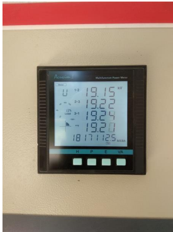
Gambar 4.4 Pengukuran Tegangan saat disuplai PLTBg Gardu Hubung PLTBg PT. Asian Agri, 2019
