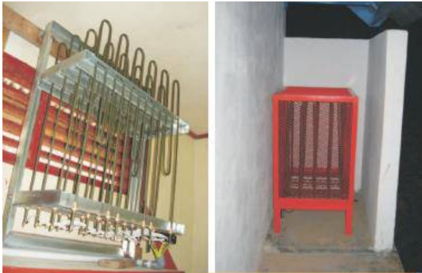
Gambar 2.9 Ballast Load berupa Air Heater
