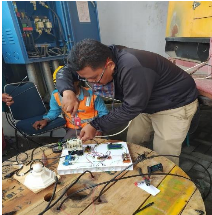
Gambar 4.1 Pemasangan Pin Kontaktor Sumber: Penulis,2020
