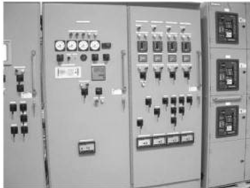
Gambar 2.1. Perangkat Hubung Bagi Jenis Konstruksi Lemari
