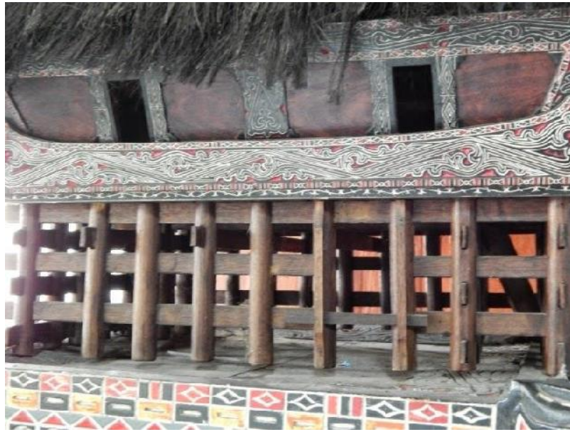
Gambar 2.4 Pondasi Rumah Batak Toba
