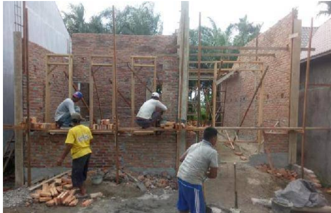
Gambar 2.12 Pembangunan rumah Sumber : Pemilik Rumah, 2018
