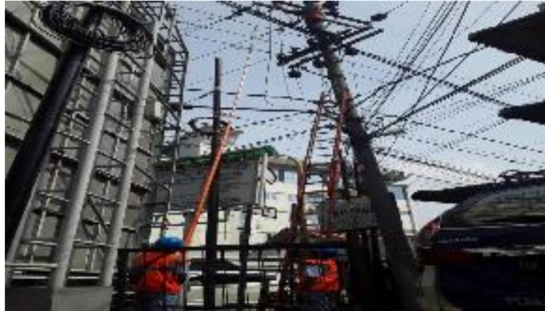
Gambar 2.1 Saluran Udara Tegangan Menengah
