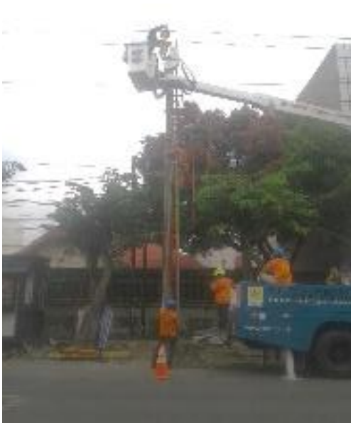
Gambar 4.5 Penggantian Isolator
