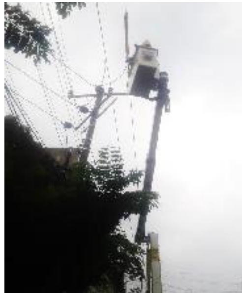
Gambar 4.6 Penjumperan Kabel Baru
