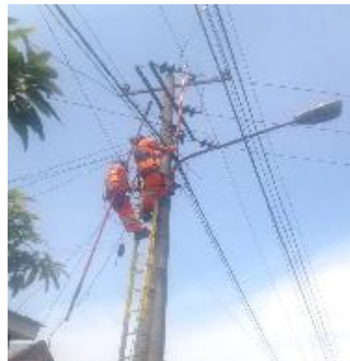
Gambar 4.2 Pemutusan Kabel Jumper
