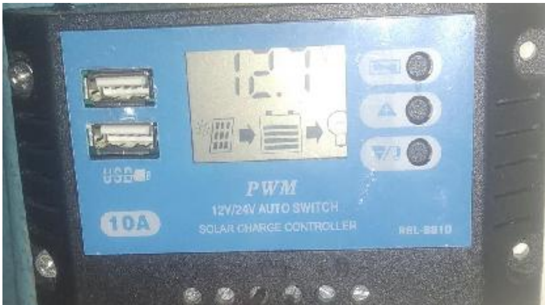
Gambar 4.3 pengukuran tegangan dari panel surya Sumber: penulis 2020
