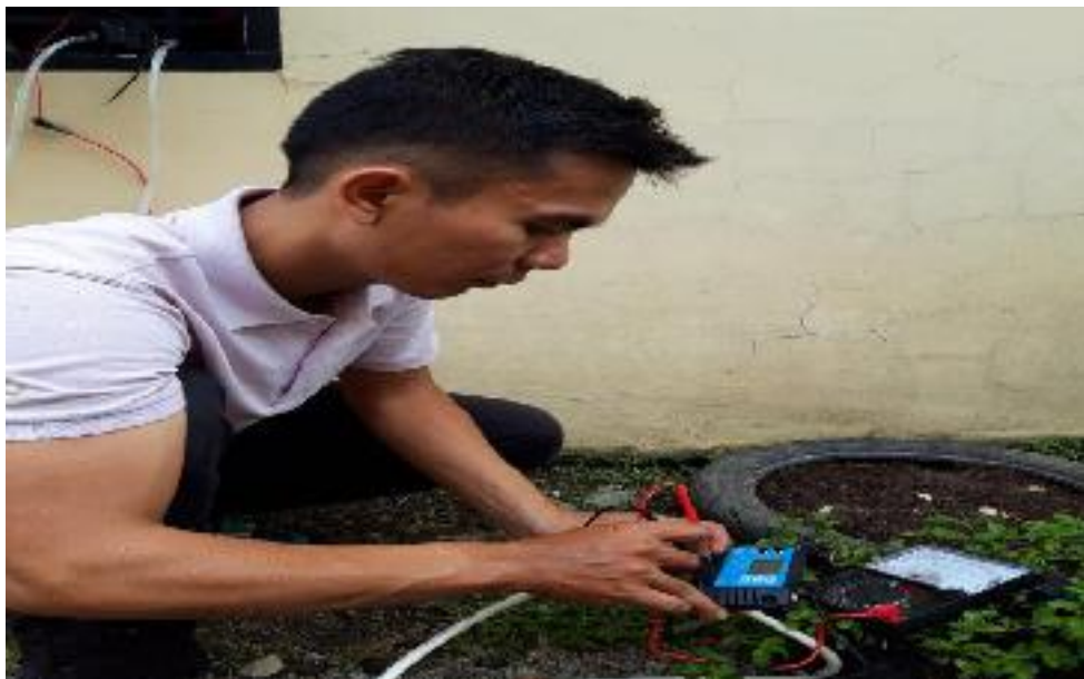
Gambar 4.5 pengukuran tegangan Output Scc Sumber: penulis 2020
