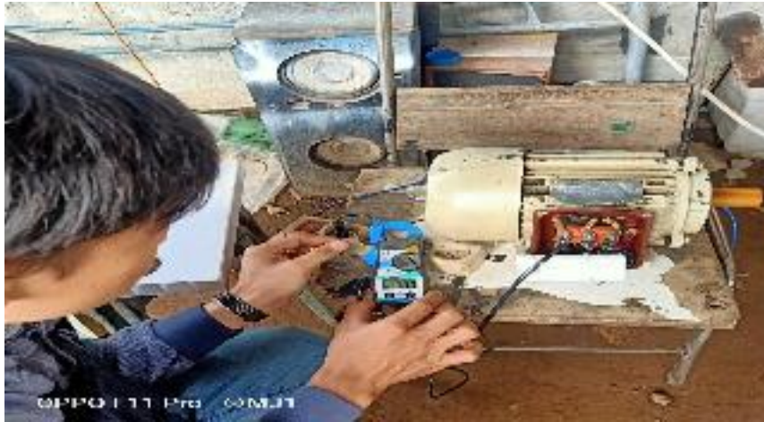
Gambar 4.2. Pengukuran Motor 3 Phase Tanpa Beban
