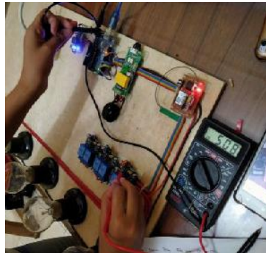
Gambar 4.6 Pengukuran Relay tanpa Beban Sumber : Penulis, 2020
