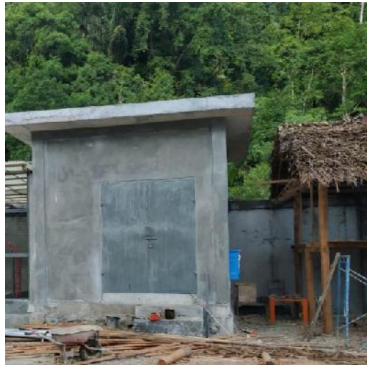
Gambar 2.6 Gardu Beton
